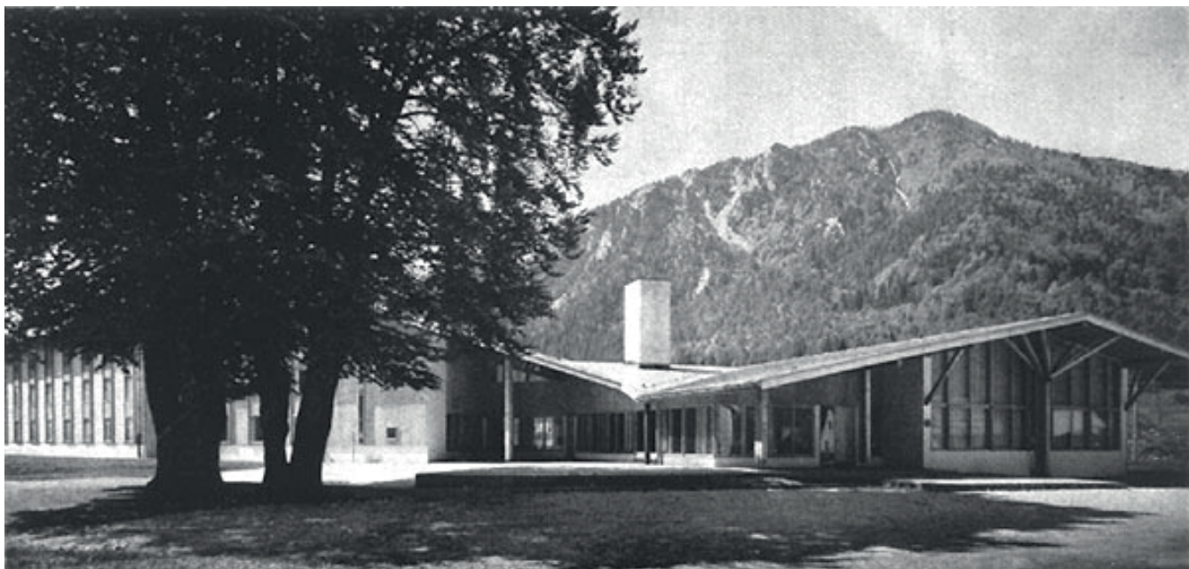
OBJEKT HOTELA PISANK, AVTORJA JANEZA LAJOVICA, ZGRAJEN LETA 1992 V KRANJSKI GORI, JE BIL KLJUB PRIZADEVANJEM PO VAROVANJU, APRILA 2003 PORUŠEN.
