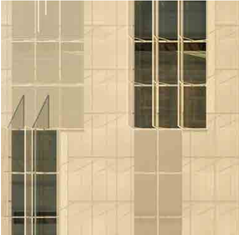
OTKLOPNI BRISOLEI NA FASADI
