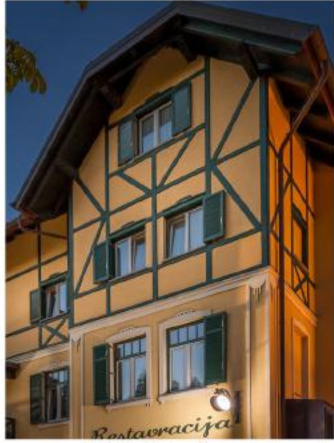
HOTEL TRIGLAV IN MNOGE STAVBE IZ TISTEGA ČASA SO GRAJENE PO PRINCIPU PREDALČNE GRADNJE.
