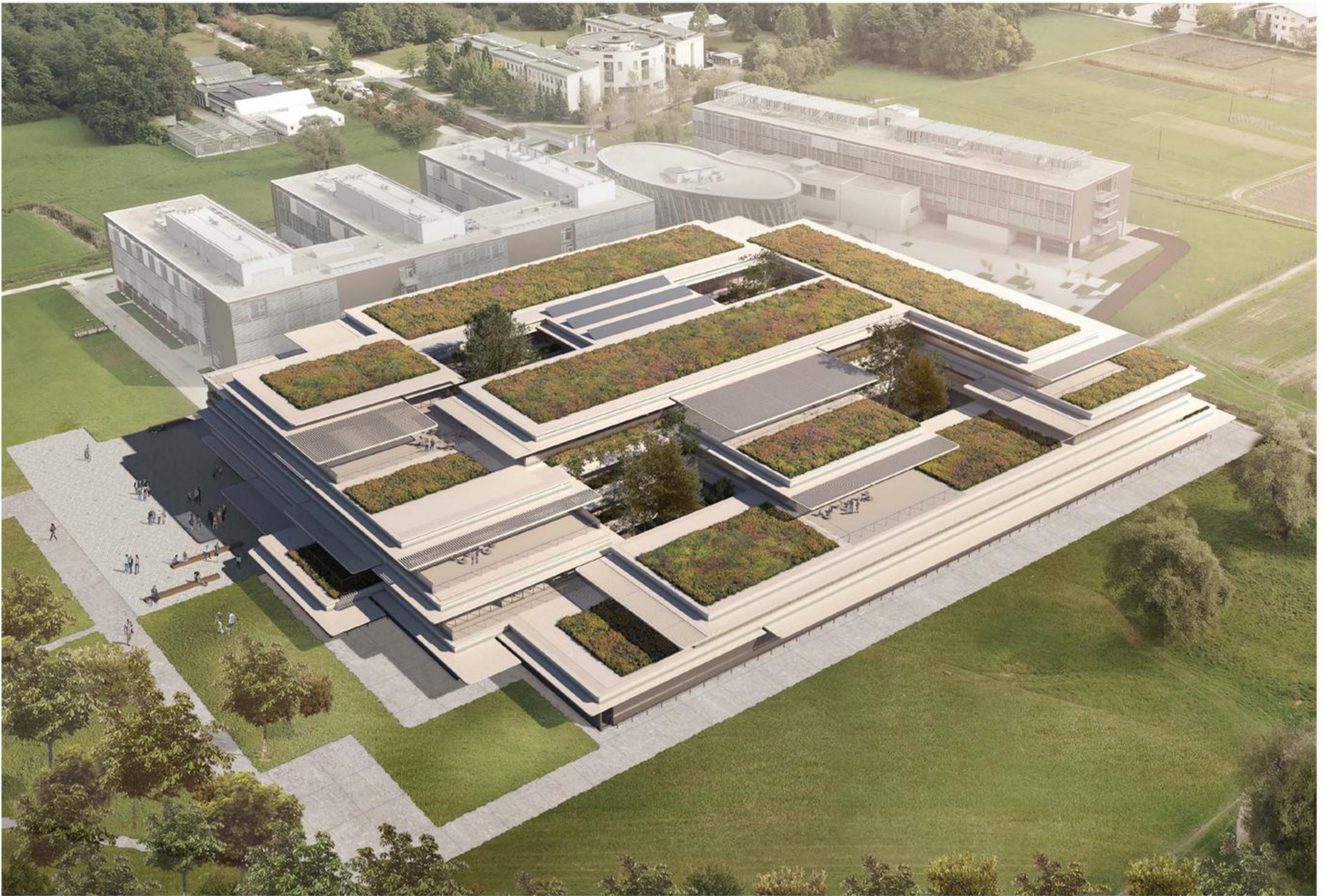
NOVA STAVBA FS DELUJE KOT SODOBNA STRUKTURA NALOŽENIH HORIZONTALNIH RAVNIN RAZLIČNIH VELIKOSTI IN OBLIK. RAVNINE SE KRIŽNO NALAGAJO OD JZ DO SV IN OMOGOČAJO ZVEZNO PREHAJANJE ZELENEGA PROSTORA OB PST PREKO ATRIJEV IN ZELENIH TERAS PROTI OBSTOJEČIM STAVBAM FAKULTET ZA KEMIJO IN RAČUNALNIŠTVO. HORIZONTALNE RAVNINE SO NALOŽENE NA NAČIN, DA OMOGOČAJO OPTIMALNO OSVETLJENOST DELOVNIH PROSTOROV PO CELOTNI GLOBINI STAVBE.
