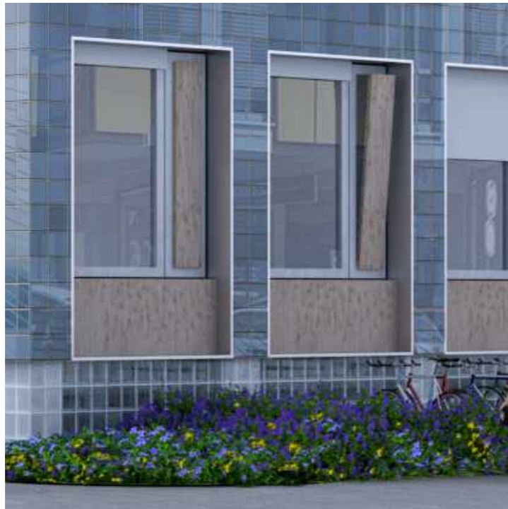
Sistem naravnega prezračevanja, senčenja in osvetlitve.
