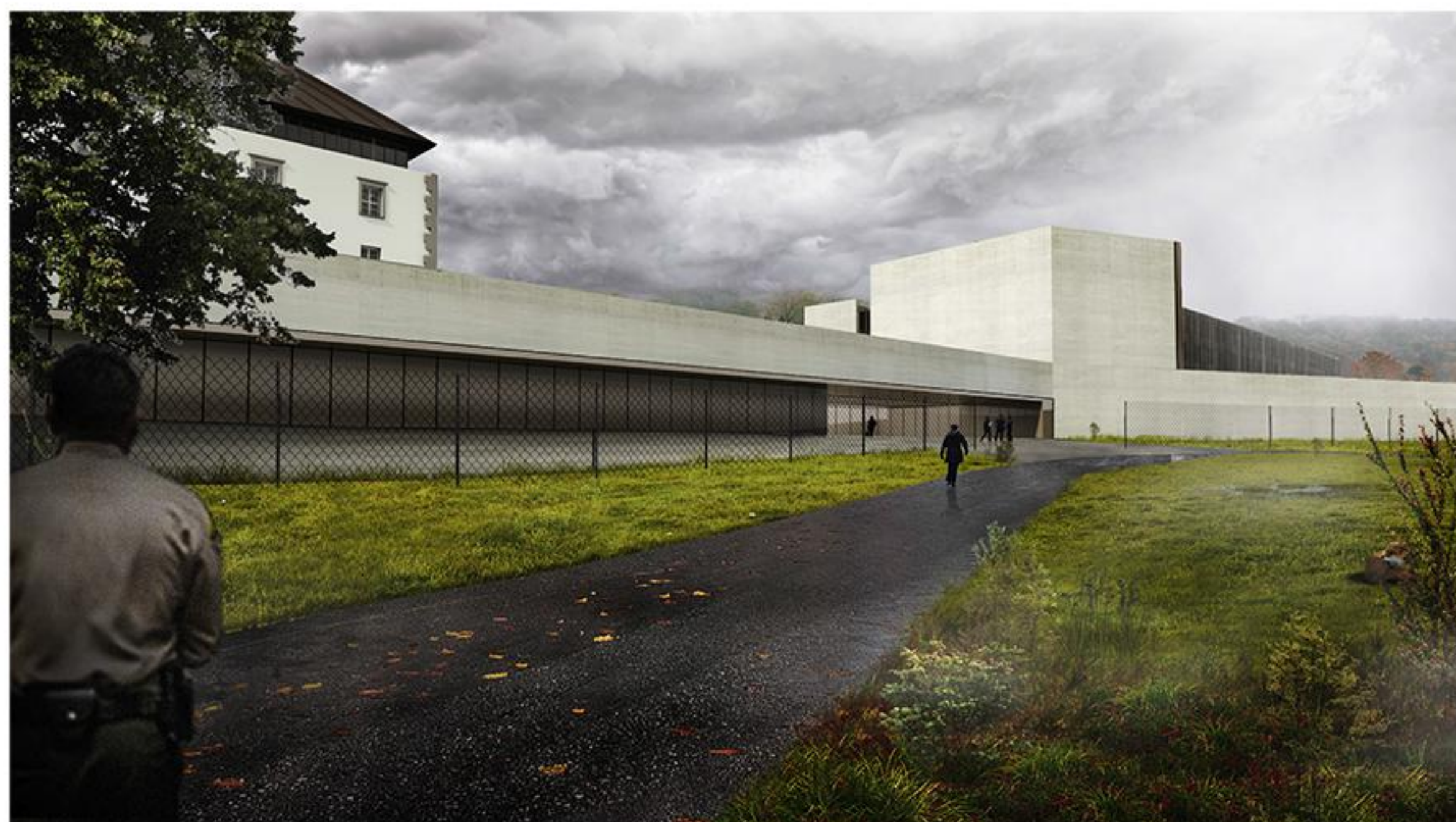
6. POGLED PRIHODA V ZAPOR
