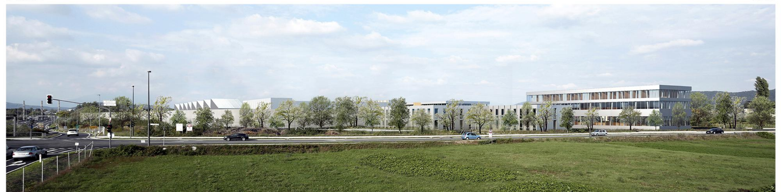
pregled na kompleks iz zveznaboda
