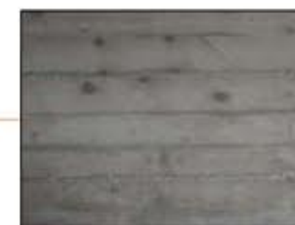
struktura betona (rebar)
