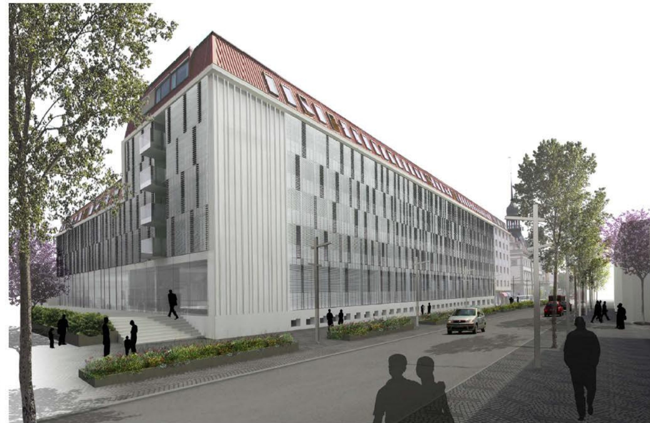
pogled na novo fasado objekta Elektra
