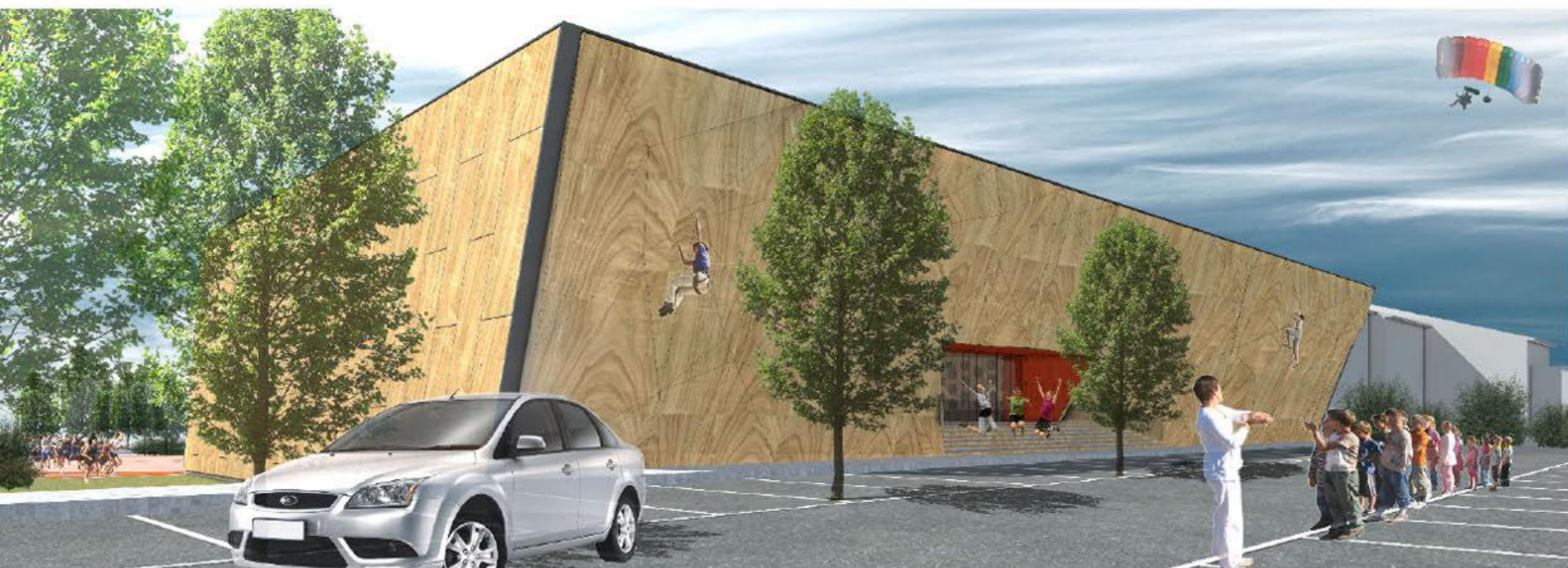
pogled z dovoznega parkirišča
