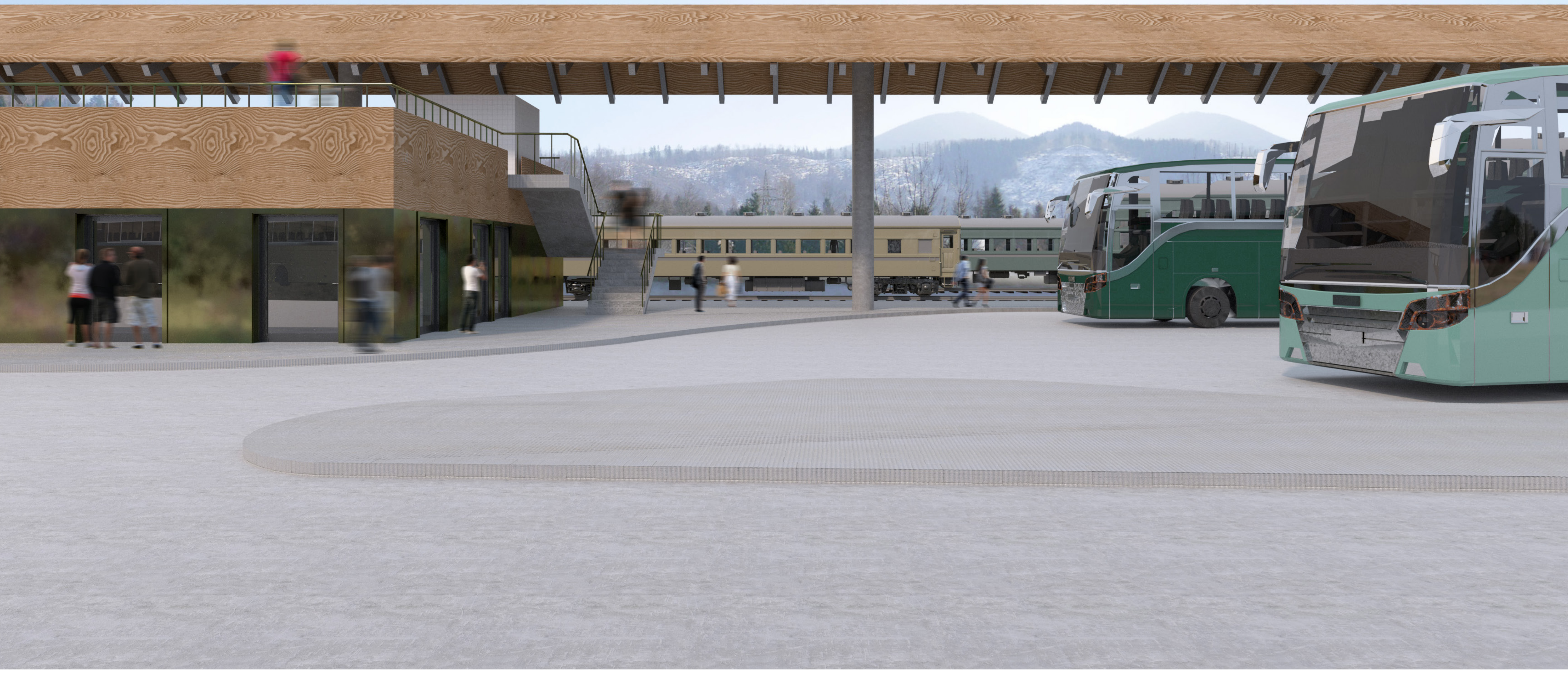
Pogled proti nadstrešku in novemu objektu
