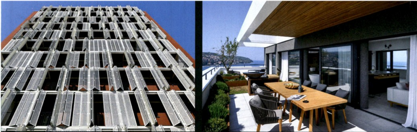
Tudi v arhitekturi in gradnji je trajnost vedno pomembnejša. Eden od primerov trajnostnega delovanja je energetska in statična sanacija Tomosove stolpnice v Kopru.
