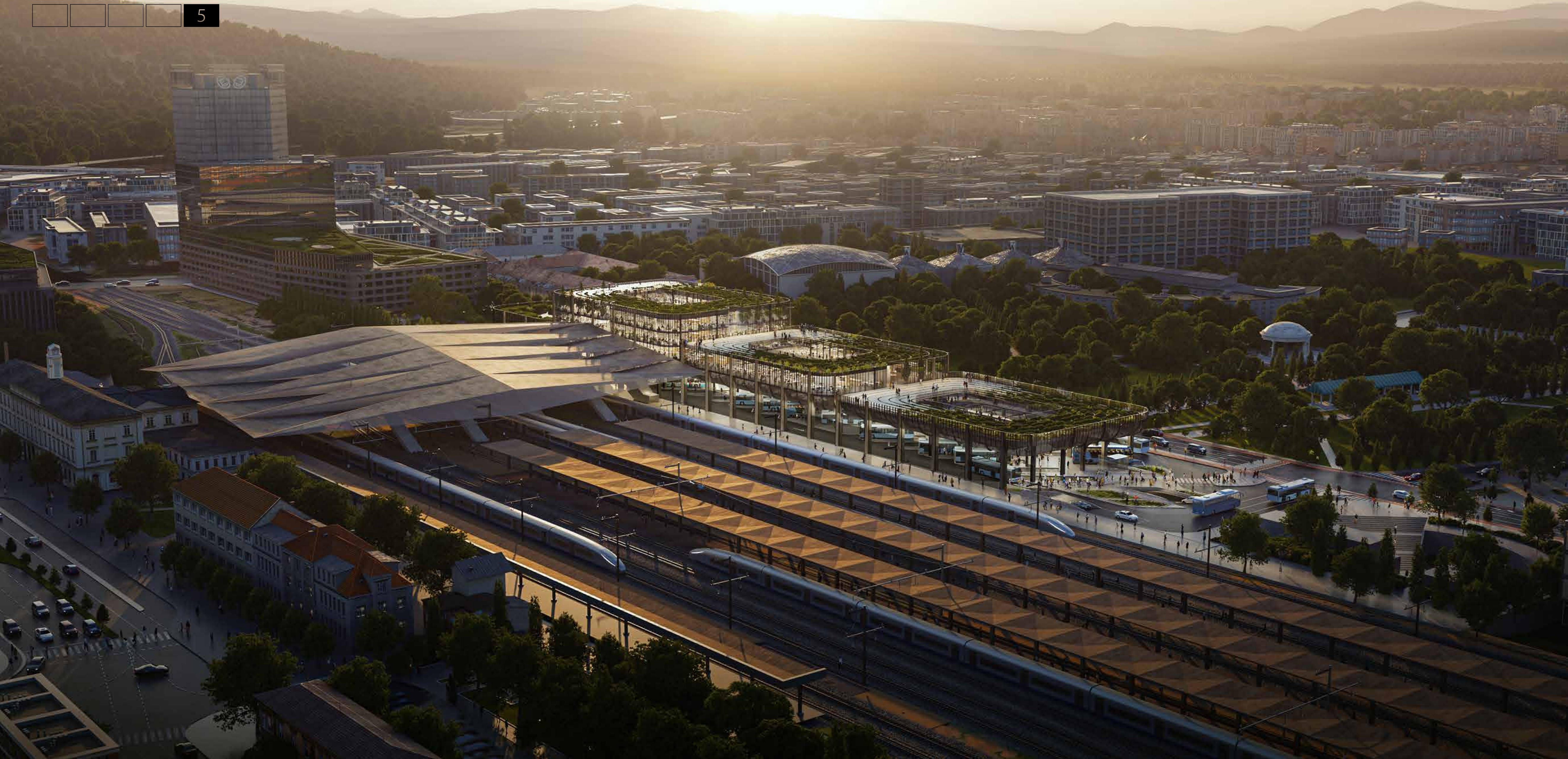
POGLED Z JV STRANI NA JUŽNO FASADO
