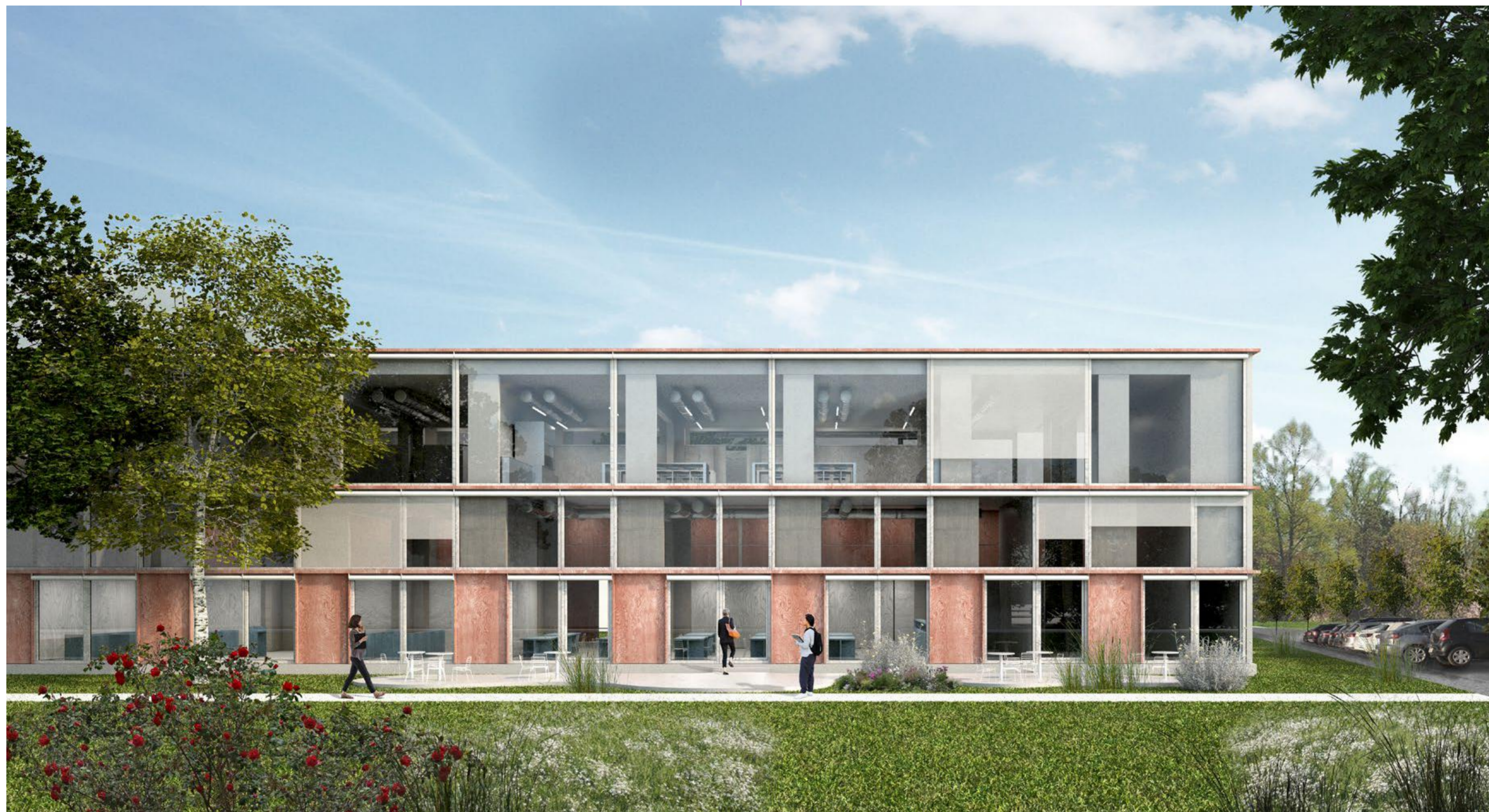
VRTNA FASADA RAZKRIVA VEČPLASTNOST PROJEKTA: DVOVIŠINSKI JAVNI PROGRAMI Z GALERIJO KABINETOV V PRITLIČJU, NAD NJIMI TEHNOLOŠKO ZAHTEVNEJŠI LABORATORIJI.
