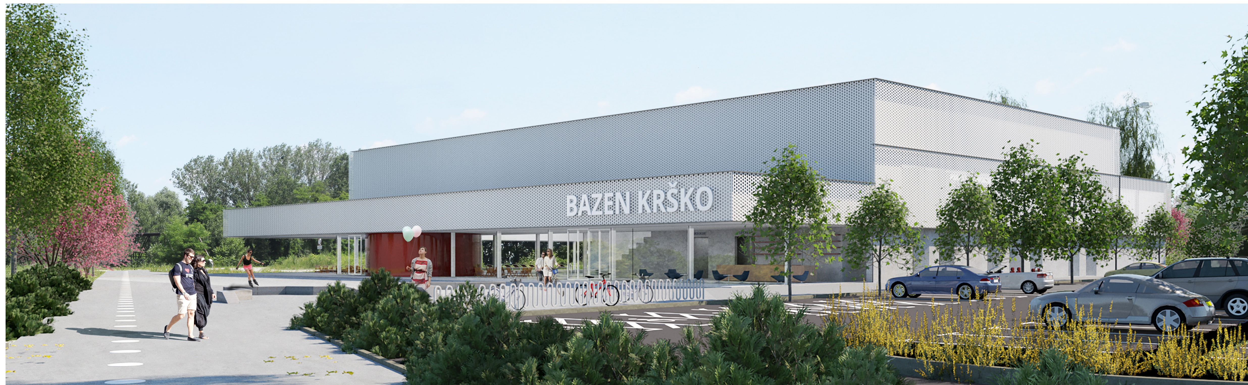
PROSTORSKI PRIKAZ Z DOVOZNE CESTE (JV)
