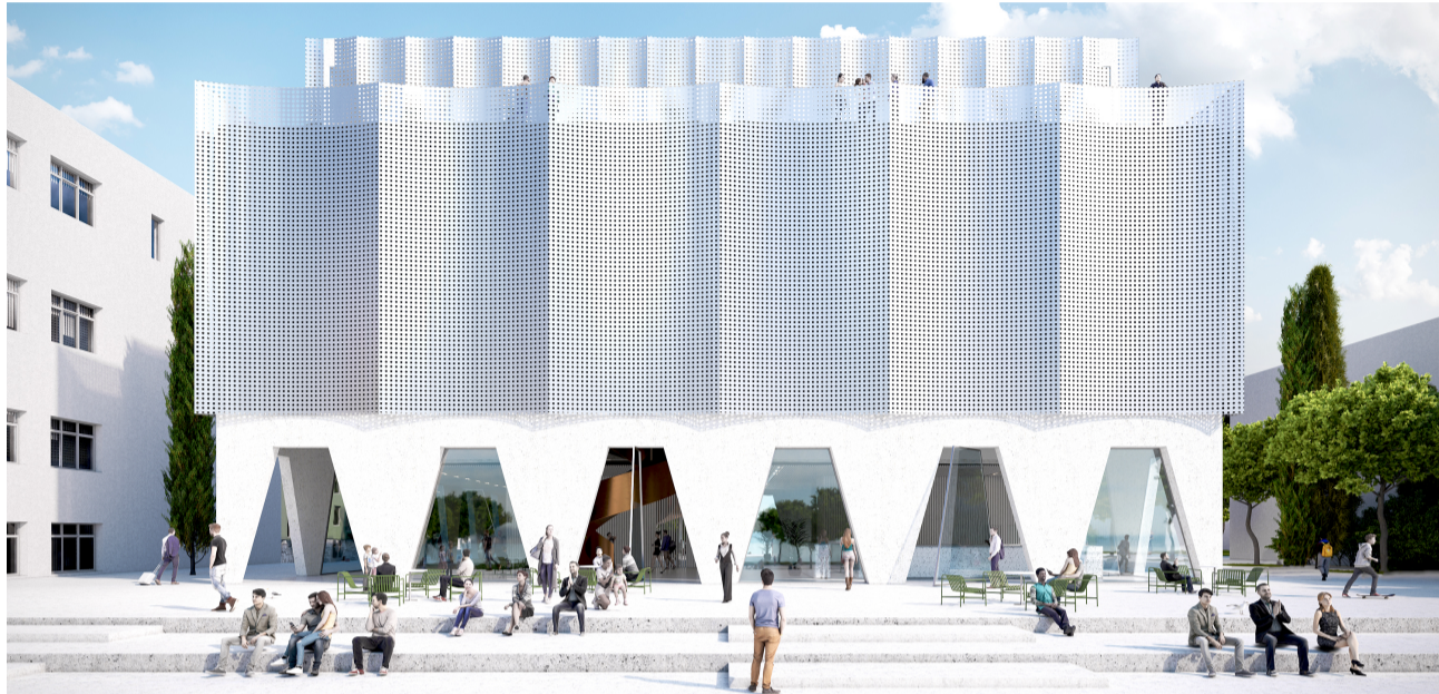
ZARADI VIŠINSKE RAZLIKE MED PRITLIČJEM KULTURNEGA CENTRA IN OBALO SE TRG STOPNJEMA SPUŠČA V SMERI OBALNE PROMENADE IN TAKO OBLIKUJE KASKADNO STOPNIŠČE
