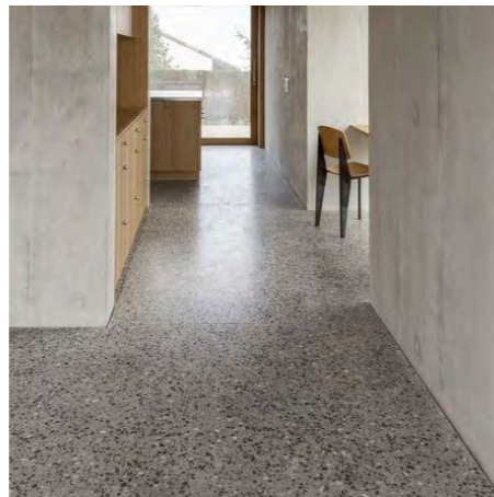
polirana betonska tla
