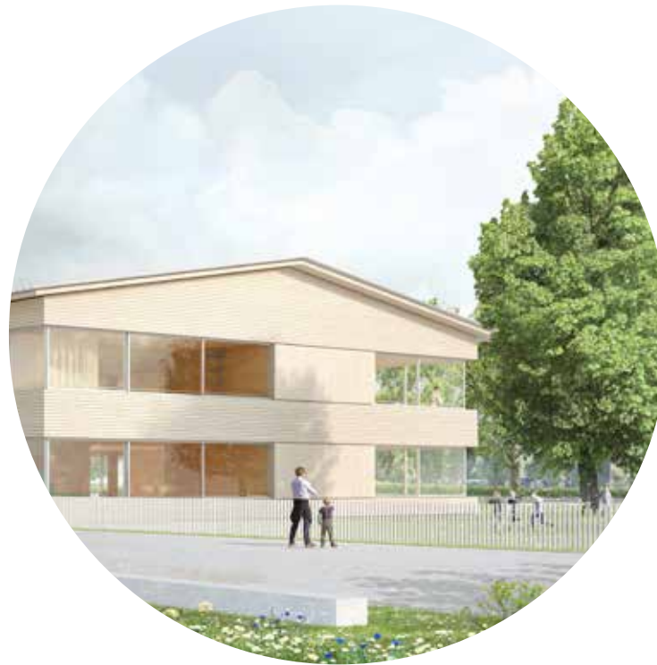
Vstopni trg Vrtca Sonček je zasnovan natančno v osi zvonika na Pungertu. Povezuje vse smeri dostopa, parkirišče pod krošnjami dreves, otroško igrišče in glavni vhod v vrtec. Je prostor srečevanja otrok, staršev in vzgojiteljev tudi po pretečenem varstvu.
