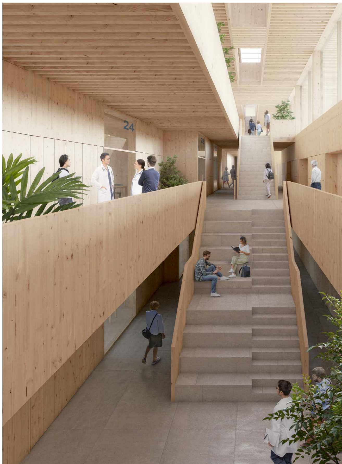
Vidna konstrukcija sten - križno lepljene plošče
