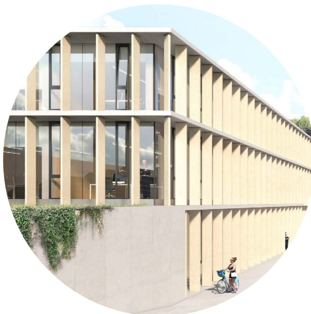
Globoko fasado sestavljajo horizontalni betonski pasovi in kamnita vertikalna senčila
