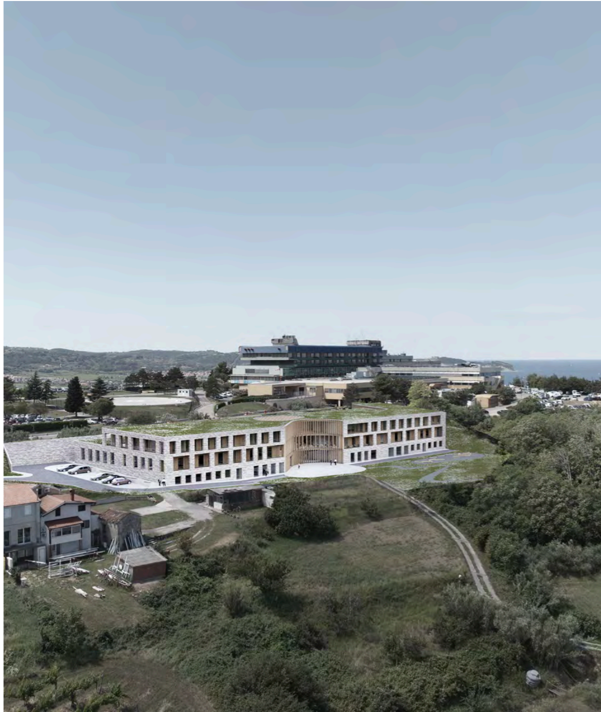
Pogled na celotno območje novogradnje.
