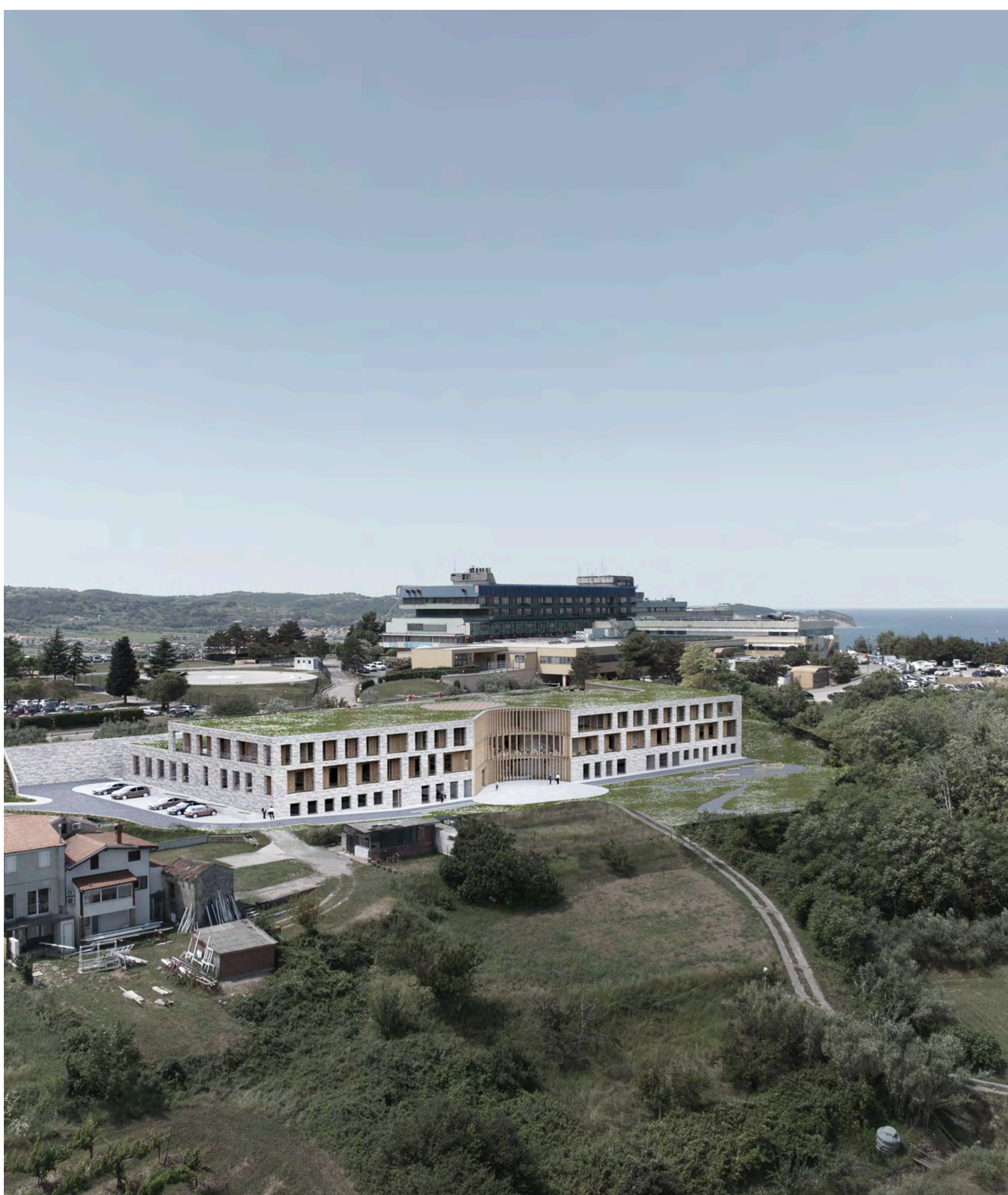
Pogled na celotno območje novogradnje.
