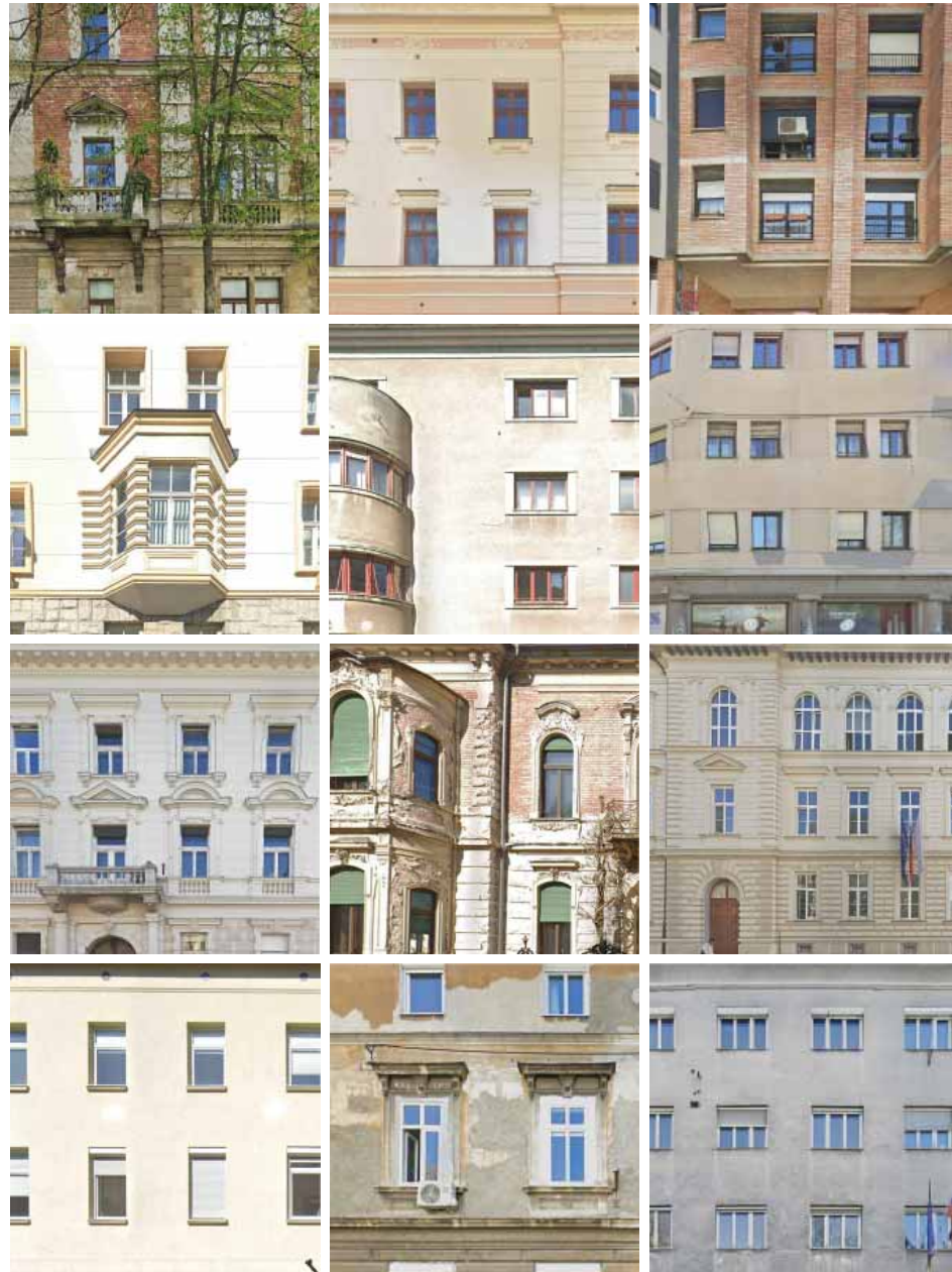
ulične fasade na Resljevi cesti: izhodišče za barvno in likovno zasnovo objekta
