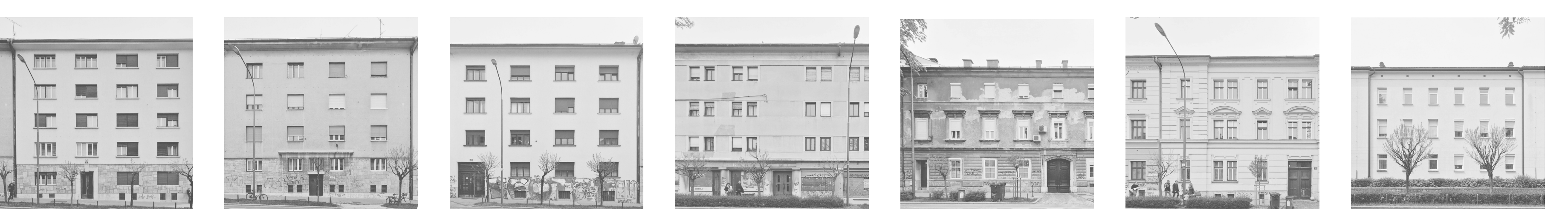
FASADE OB RESLJEVI ČESTI ZAZNAMUJEJO ENOSTAVNE PRAVOKOTNE OKENSKÉ ODPRTINE RAZPOREJENE NA ORTOGONALNI MREŽI S COKLOM, VISOKIM PRITLČJEM IN VENCEM OBLIKOVNI KONTEKST FASAD
