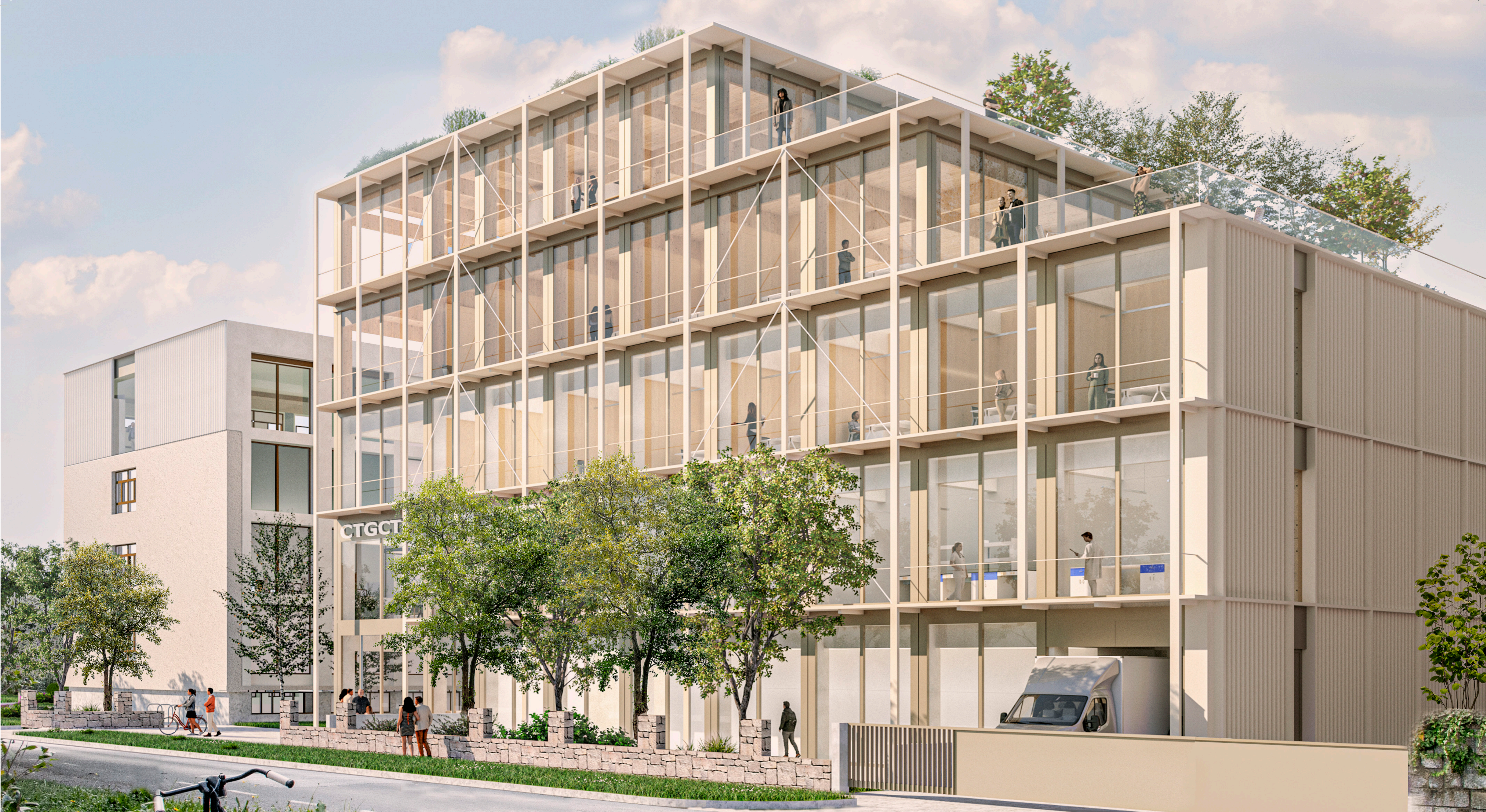
Pogled na navzven vidno modularno sestavo novega objekta, ki se z ozelenjenimi terasami volumensko spušča proti severu.
