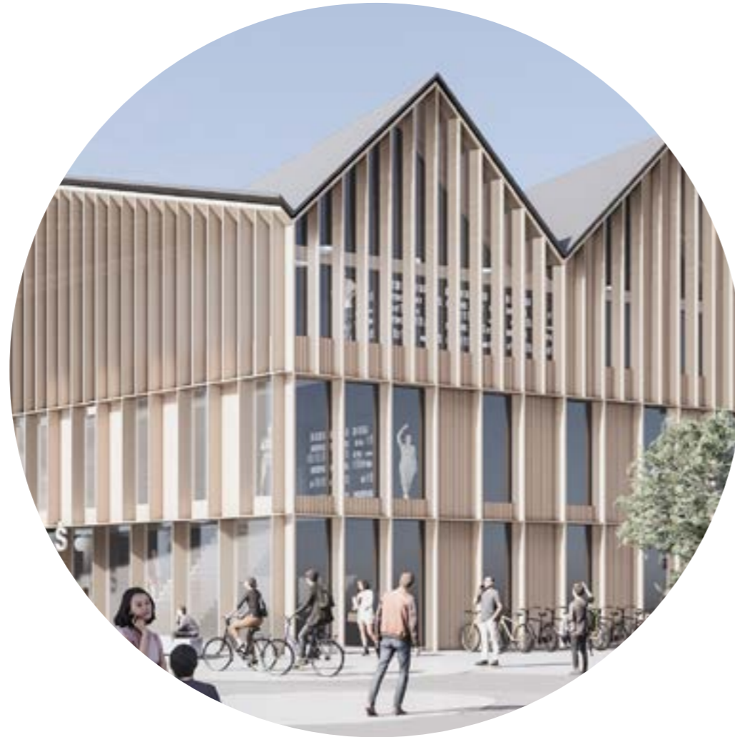
Globoko fasado sestavljajo horizontalni pasovi in vertikalna senčila
