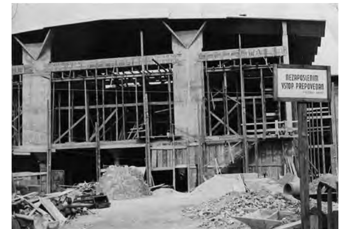
Dvoranska stavba v času gradnje, avtor fotografije neznan
