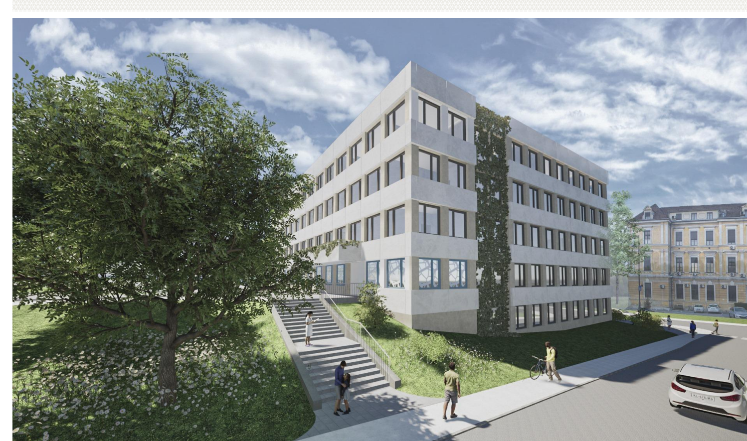
POGLLED NA JUGOZHODNI VOGAL
