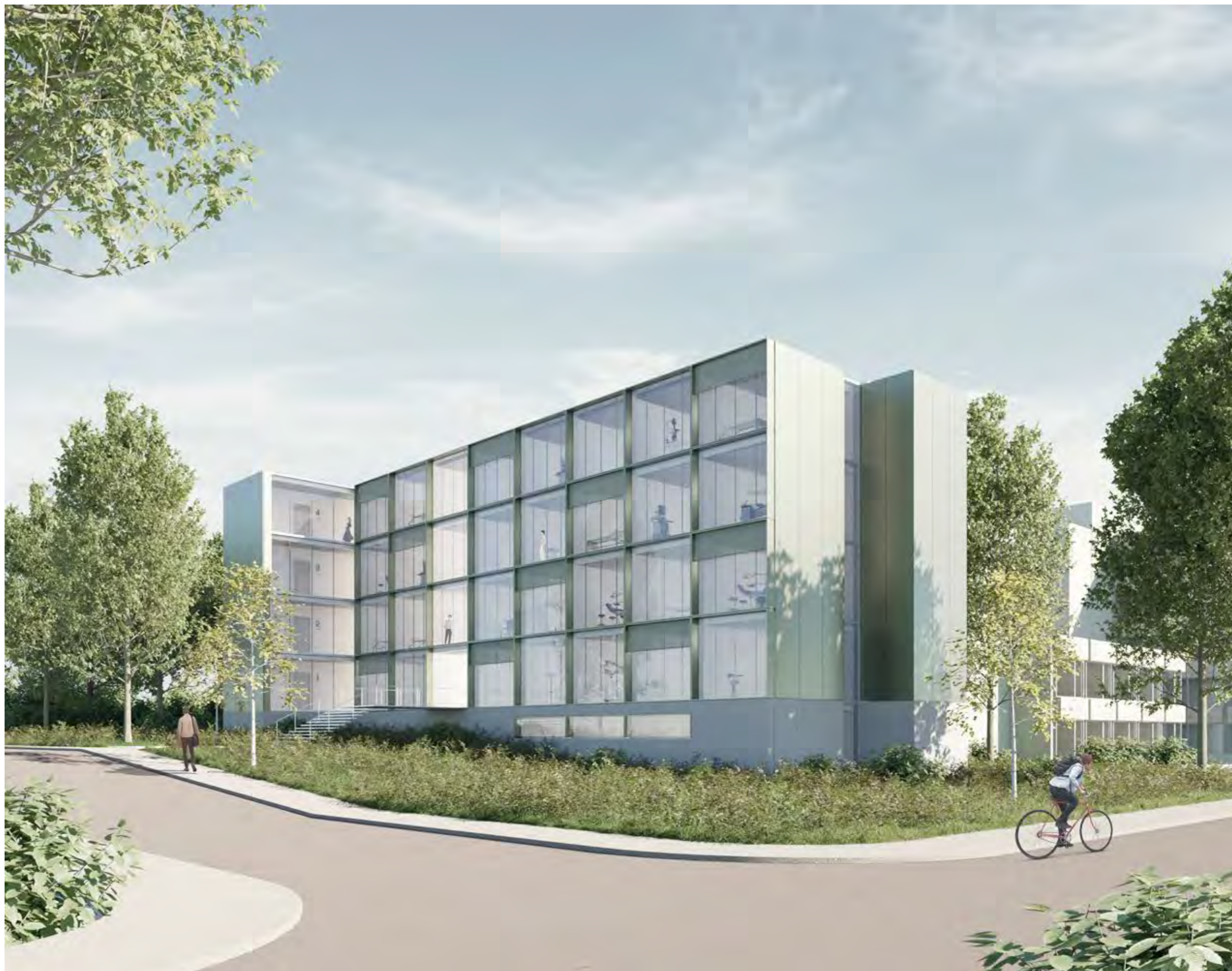
pogled s Kandijske ceste na severovzhodni del novega objekta
