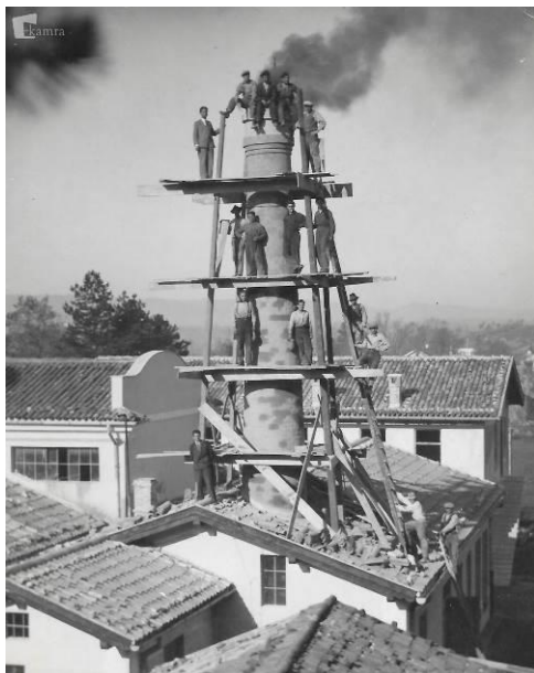
Slika 22: Gradnja dimnika leta 1935, viden je zaključek strehe po vzoru sprednje fasade, vir: kamra.si
