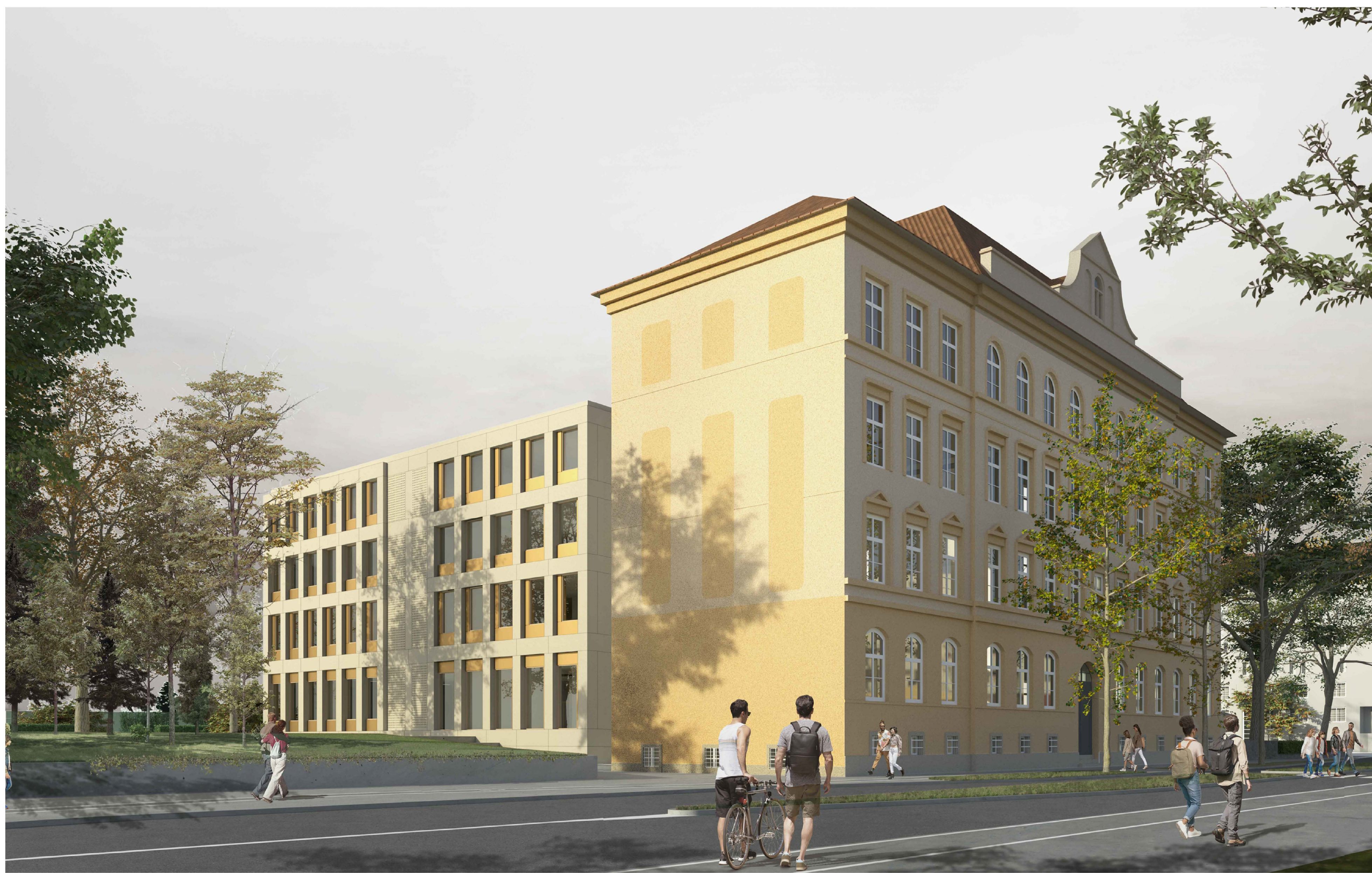
Pogled iz Gosposvetske ceste - prizidek se kot rokavica prilaga obstoječi dominantni zgradbi
