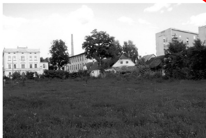
kompleks Univerzale in stanovanjsko-poslovni objekt Krizant
