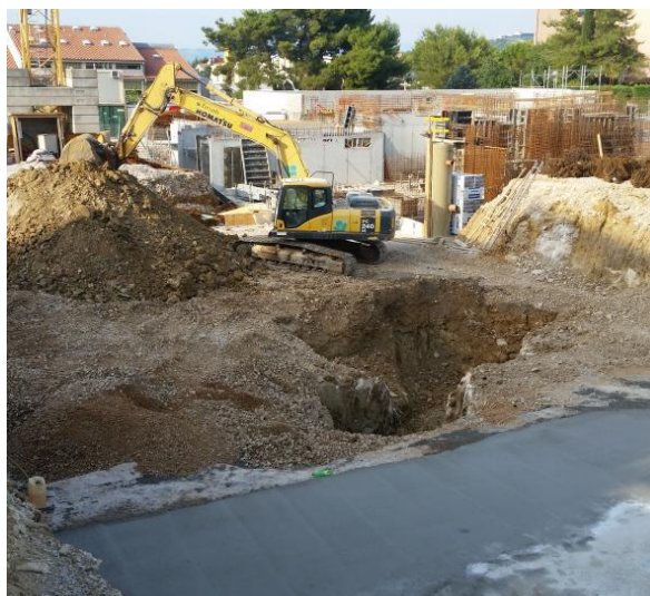
Slika 6: Dno izkopa gradbene jame v Izoli s kraškimi pojavi (škrape, vrtače, kaverne)
