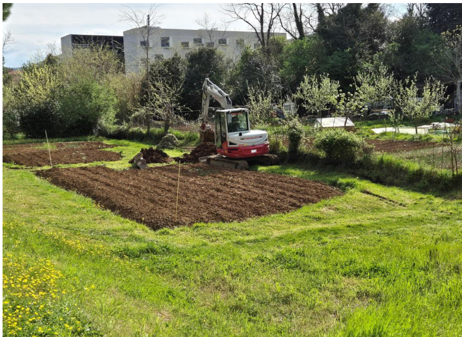
Slika 2: Lokacija sondažnega jaška SJ-1 na parceli bodoče novogradnje
