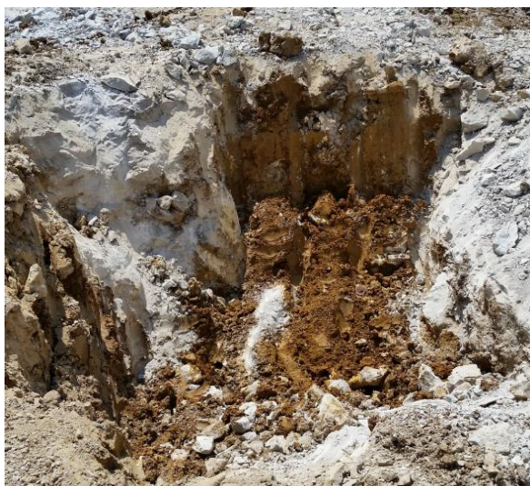
Slika 6: Dno izkopa gradbene jame v Izoli s kraškimi pojavi (škrape, vrtače, kaverne)
