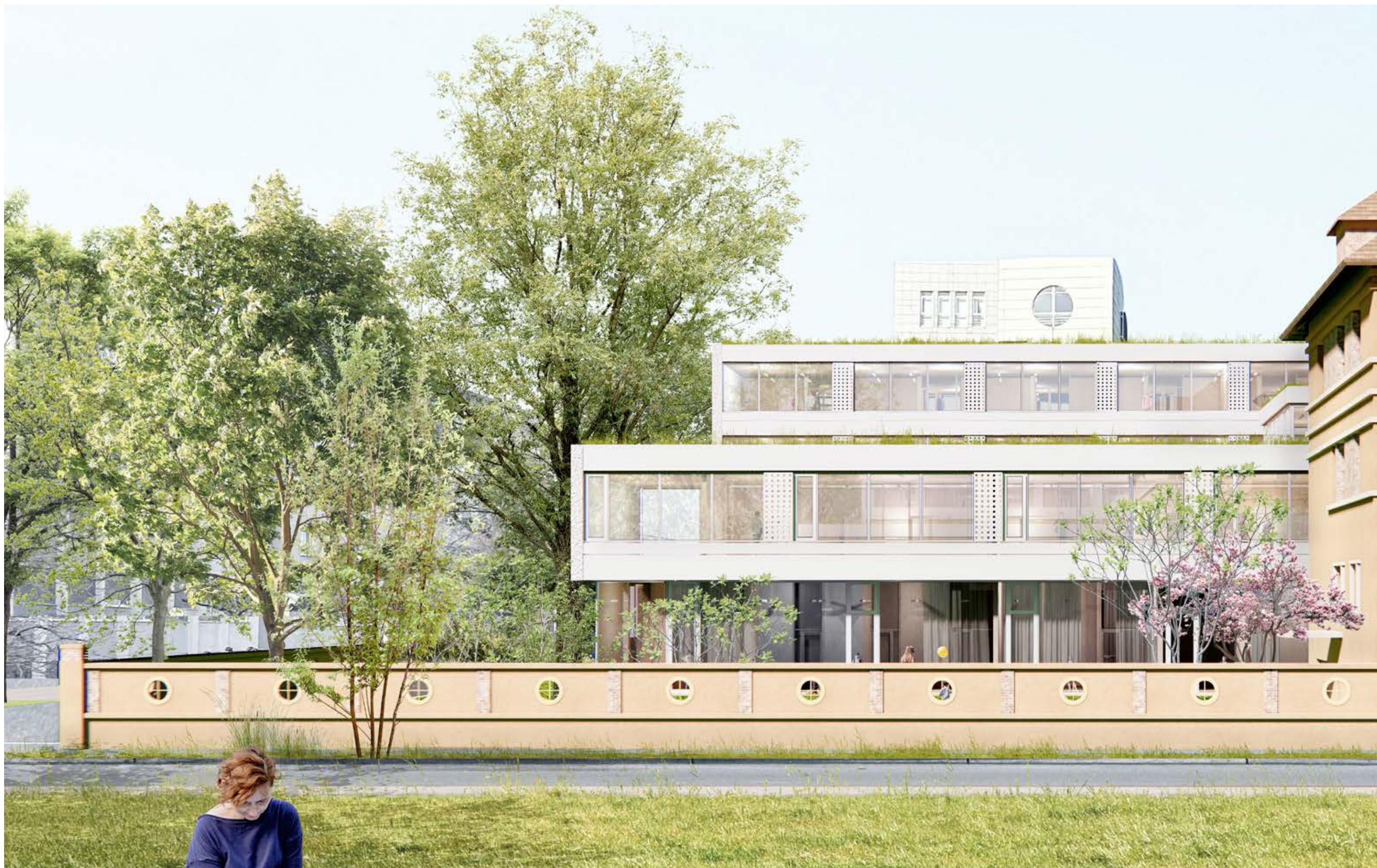
POGLED IZ TOSCANINIJEVEGA PARKA NA PRENOVLJENI OBJEKT DOMA IN NOVI ŠOLSKI CENTER IRIS
