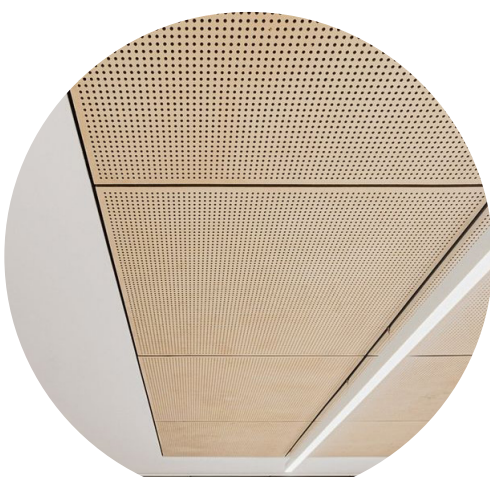
akustični leseni strop avtobusni terminal
