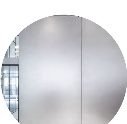
brušen inox obloge vertikalnih jeder
