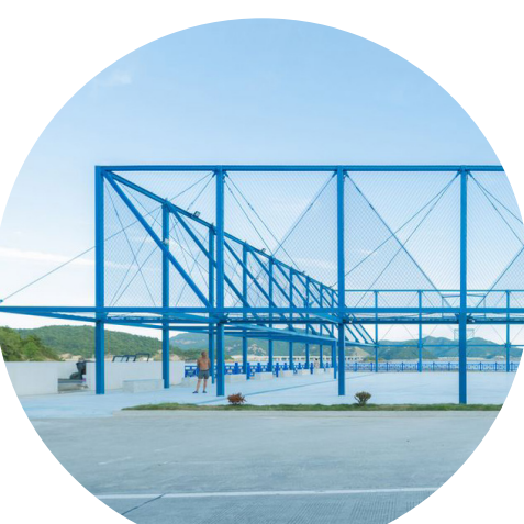
jeklena prašno barvana konstrukcija paviljonov
