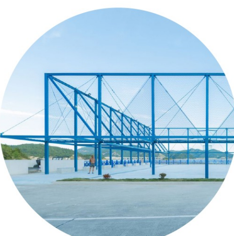
jeklena prašno barvana konstrukcija paviljonov
