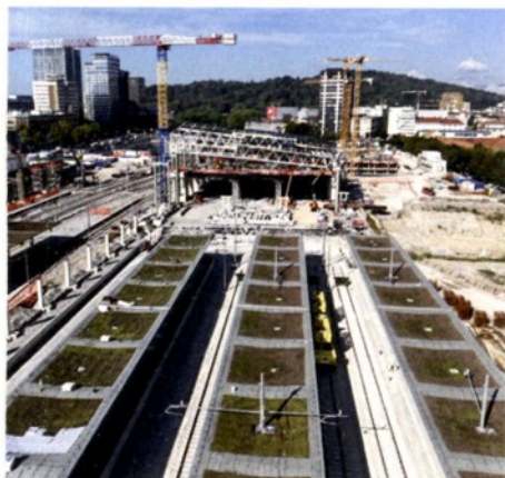
Nova železniška postaja med gradnjo
