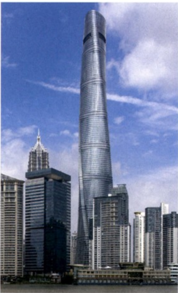
Ena izmed najvišjih stavb na svetu že deset let stoji v največjem kitajskem mestu, svetovnem finančnem središču, Šanghaj. Osrednje deblo 632 m visokega stolpa je sestavljeno iz betonskega jedra in jeklenih stebrov, obešeno fasado pa sestavlja 20.000 steklenih panelov [vir: Wikipedija]
