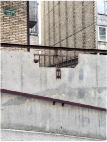
Zob časa vidnim delom betonske in železobetonske konstrukcije ni naklonjen. Na površinah se nalaga umazanija, pogosti so rjavi madeži, posledica rjavenja armature, pa tudi njegova toplotna prevodnost ni ugodna. Stavbe pestijo toplotni mostovi, rešitve brez spremembe oblike – likovnega izraza arhitekture – ni. (foto: Ž. Deu)
