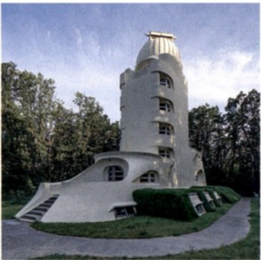
Einsteinturm v Potsdamu pri Berlinu. Stavba potrjuje avtorjevo (Erich Mendelsohn) življenjsko vodilo, da mora s svojim delom vsak umetnik pokazati svoj pogled na svet, predstaviti svoja občutenja, to pa mu omogoča novo gradivo – armiran beton (foto: https://de.wikipedia.org/wiki/Einsteinturm )
