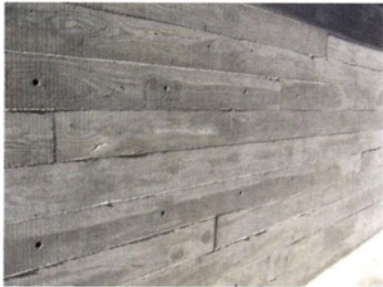
Struktura opažne površine in pozicija opaznih povezav določata videz betonske površine. Opažna ploskev je lahko narejena iz lesa, jekla ali umetnih materialov. (foto: Ž. Deu)
