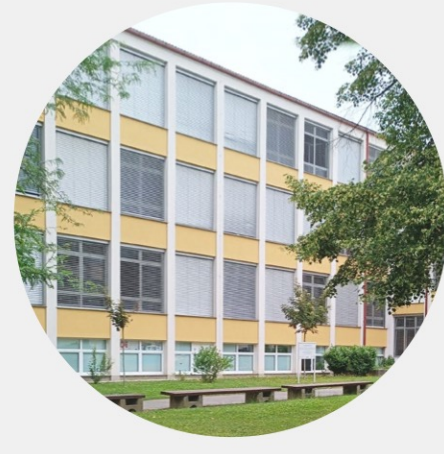
STAVBA SREDNJE TEHNIŠKE ŠOLE
