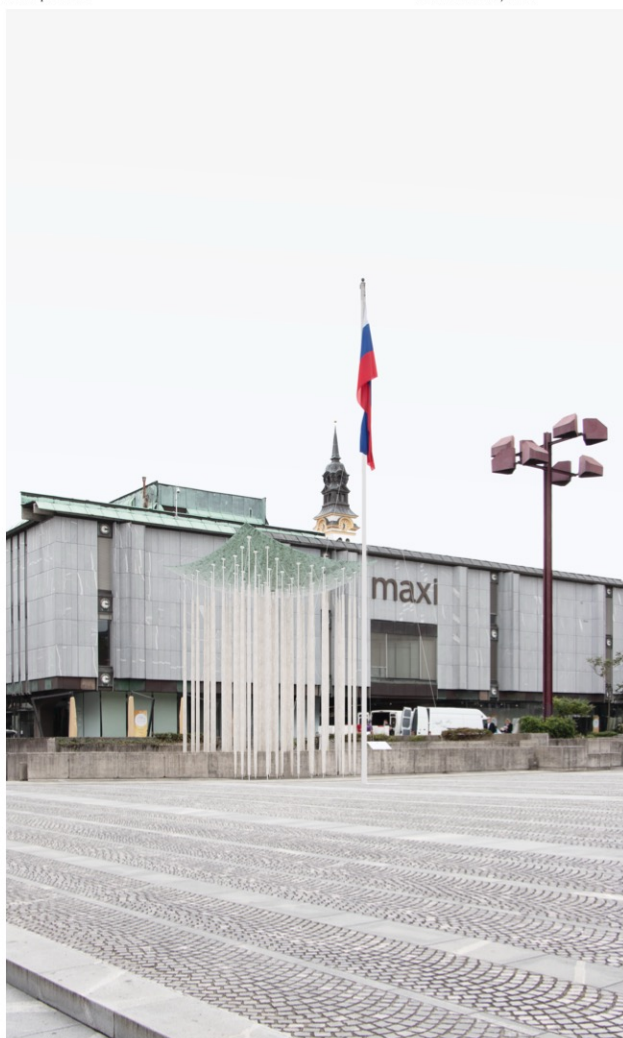
pogled iz Šubičeve ulice
