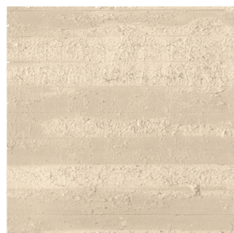
plastena betonska stena s primesom avtohtone kamnine
