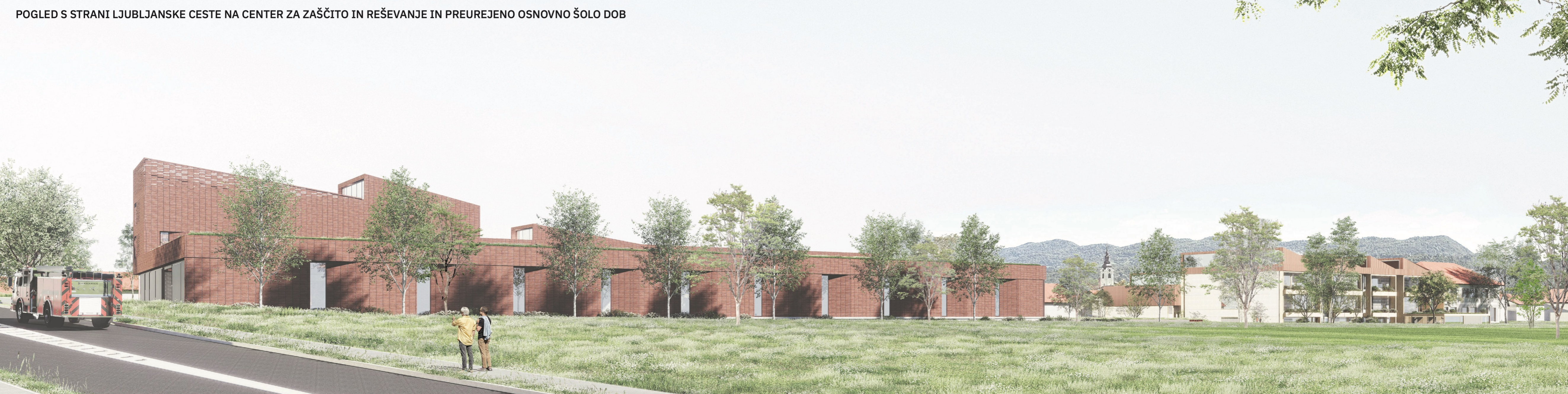
POGLAD S STRANI LJUBLJANSKE CESTE NA CENTER ZA ZAŠČITO IN REŠEVANJE IN PREUREJENO OSNOVNO ŠOLO DOB
